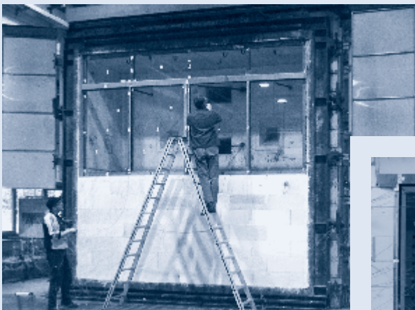
Aufbau einer 4-teiligen EI30-Anlage mit Oberlicht im Prüfinstitut. Montage d'une installation EI30 à 4 éléments avec partie supérieure à l'institut de certification.
