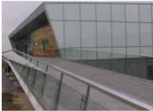
Gebäudezugang: Geländer aus Glas mit Chromstahl-Handlauf, Höhe 1.0 m.
