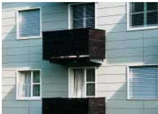
Moderner Wohnungsbau: Fassade aus Faserzementplatten, Balkone aus geschlossenen Holzbrettern, die schwer bekletterbar sind.
