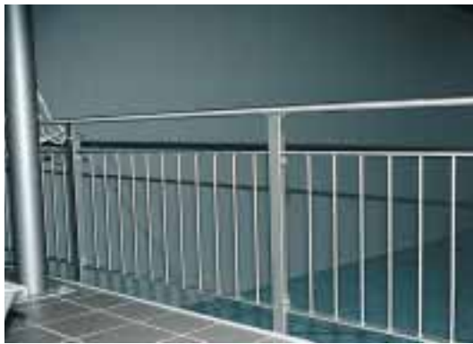
Geländer aus Vertikalstaketen: Höhe mindestens 1.1 m, schwer bekletterbar, Transparenz gewährleistet.
