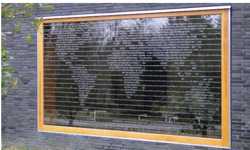
Innovative Sichtbarmachung spiegelnder Scheiben mittels Aufdruck am Auswärtigen Amt, Berlin-Tegel.
