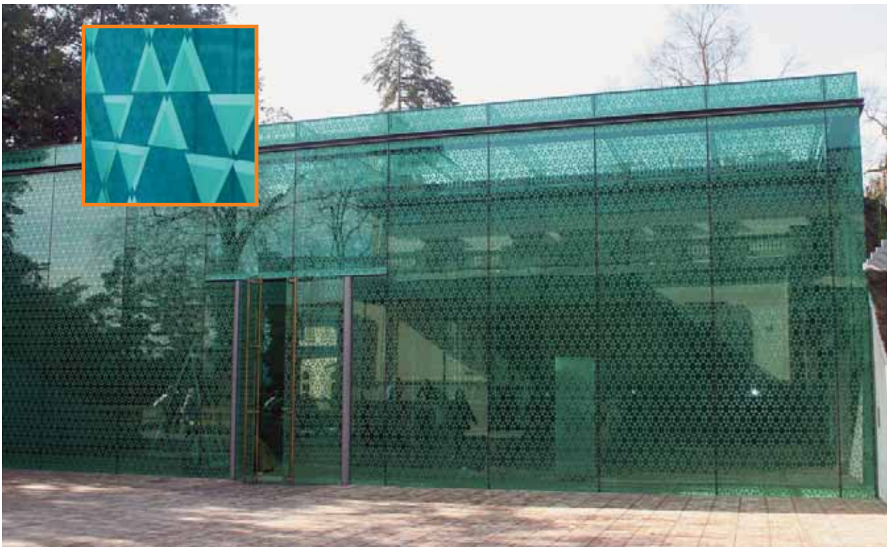
Dieser Vorbau des Rietberg-Museums in Zürich befindet sich mitten in einem Park. Er wurde – nicht zuletzt aus Vogelschutzgründen – mit durchwegs bedrucktem Glas realisiert und als «Smaragd» bezeichnet. Wahrlich ein Schmuckstück!
