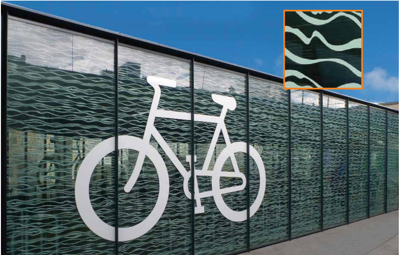
Der Siebdruck verhindert bei dieser Fahrradgarage den Vogelanprall. An der Außenseite aufgebracht würde auch noch die Spiegelung gebrochen und damit die Wirkung verbessert.
