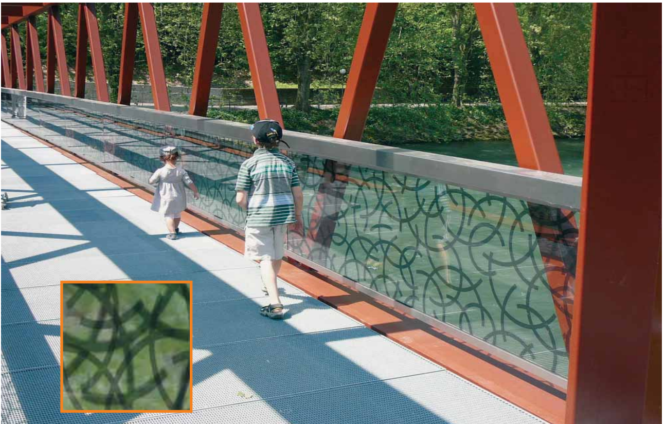
Brücken wie diese relativ knapp über den Fluss führende stehen senkrecht zur Flugrichtung der meisten Vögel. Für die Brüstung wurde hier dieses Dekor aus Kreissegmenten, die noch leicht transparent sind, gewählt. Es wirkt einerseits elegant und beschwingt. Andererseits schliesst sich das Dekor aus dem Blickwinkel des anfliegenden Vogels zu einer Art «Kettenhemd» und ist für ihn vermutlich gut erkennbar.
